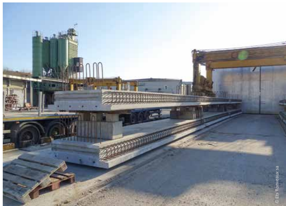
In Franières leverde Ronveaux een belangrijke bijdrage aan de realisatie van het brugdek, waarvoor het bedrijf elf volledig geprefabriceerde voorgespannen betonplaten leverde.
