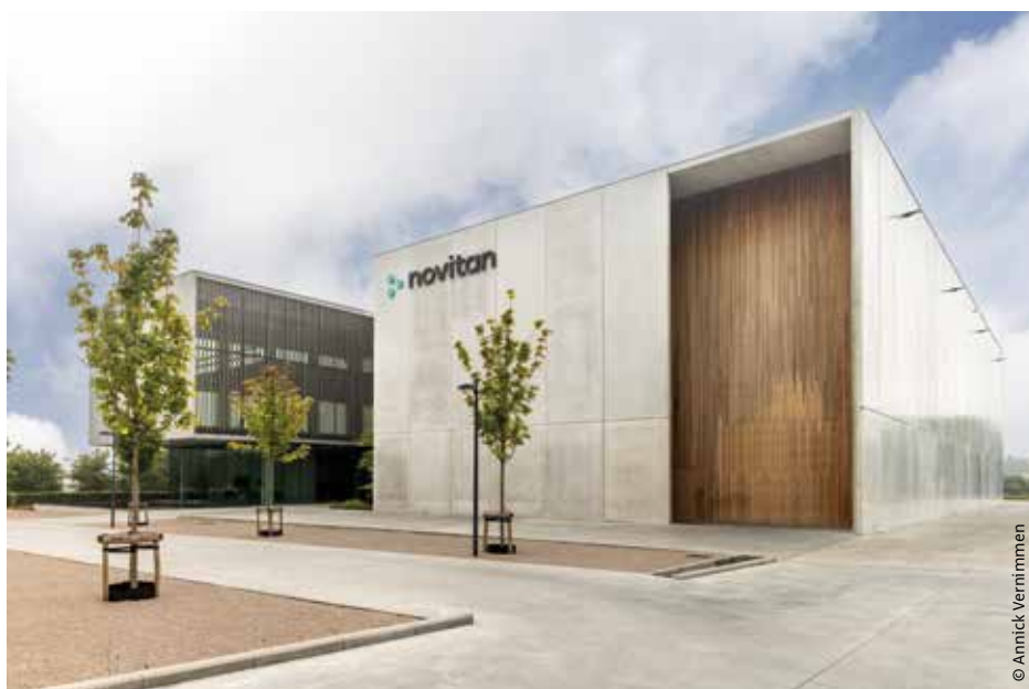
In samenwerking met Dedeyne Construct nv ontfermde Valcke Prefab Beton nv zich over de bouw van het kantoorgebouw en de loods.
