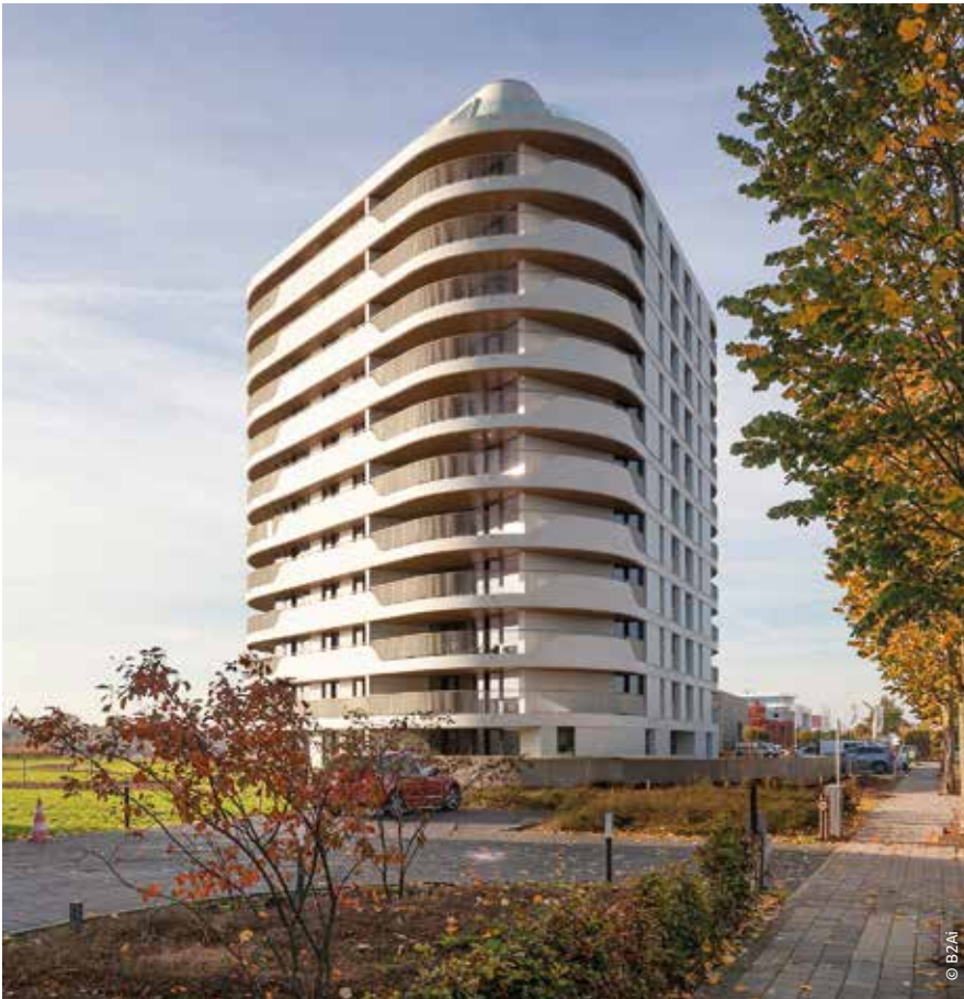
Residentie Belgica profileert zich als een rijzige woontoren op de voormalige Boelwerf in Temse.
