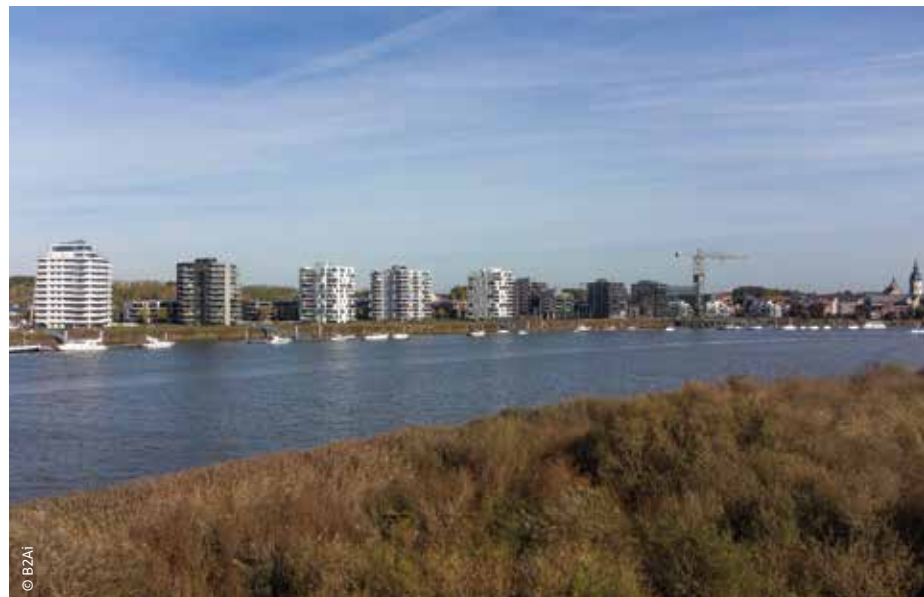
Residentie Belgica is het sluitstuk van de reconversie van de voormalige Boelwerf.
