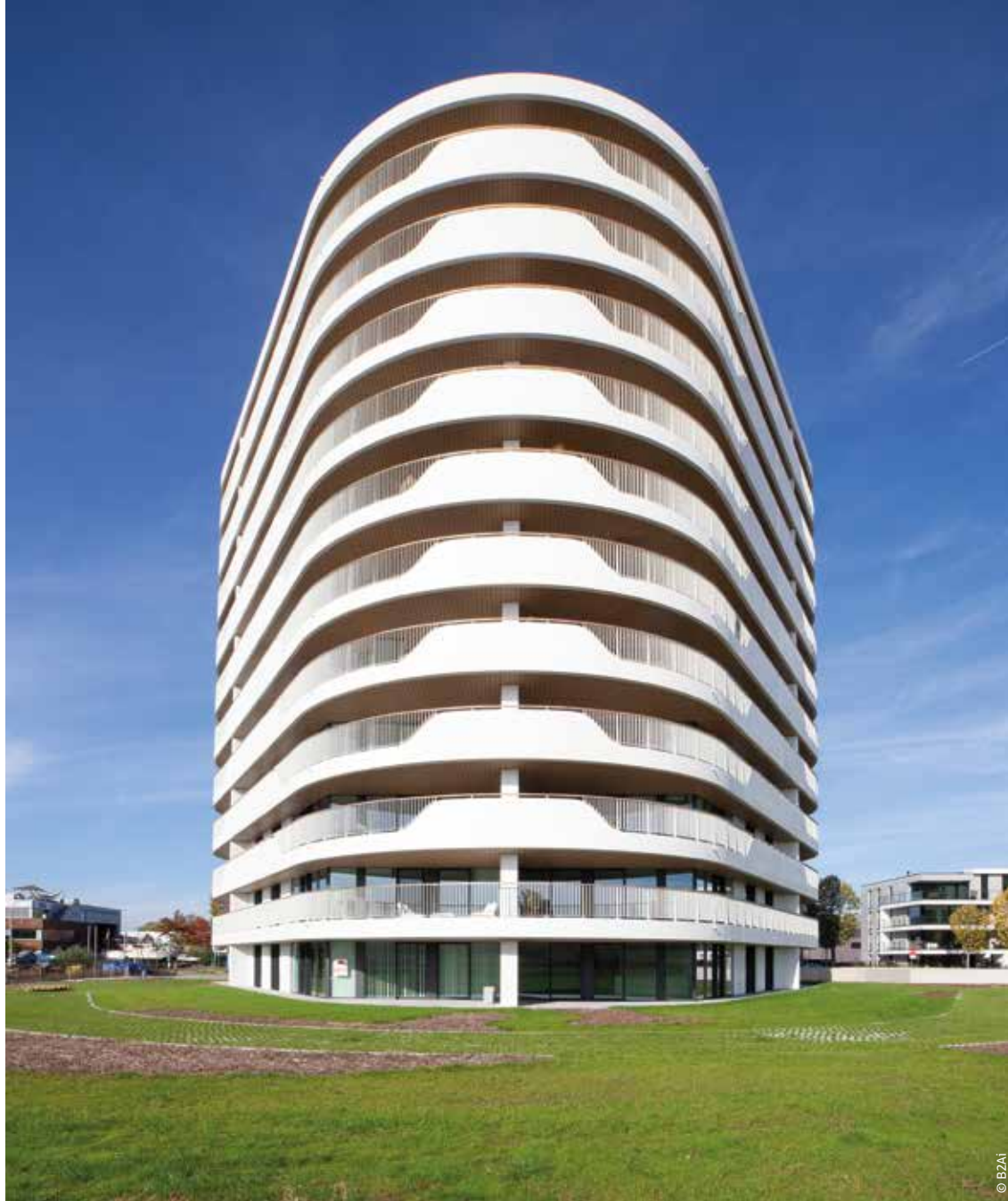
Rond het gebouw werd een groene zone aangelegd. Un espace vert a été aménagé autour du bâtiment.
