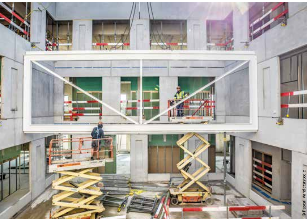
Voor een labo-gebouw voor BleuChem, ontworpen door LOW Architecten, werden heel wat prefab betonelementen structureel toegepast.
