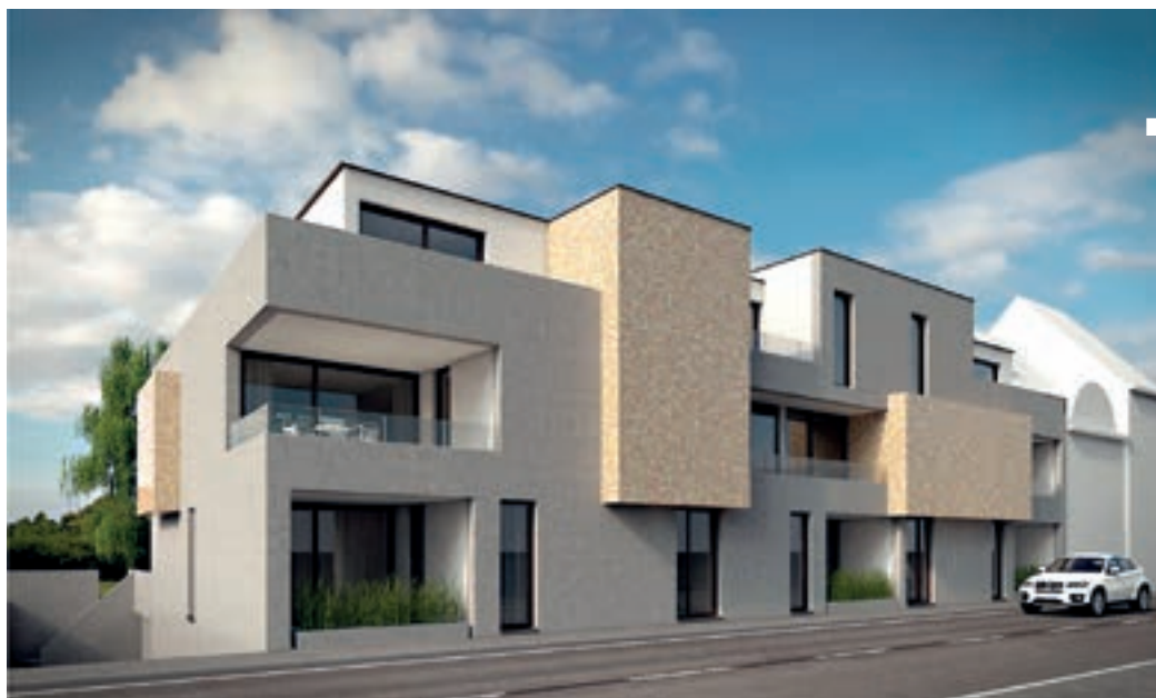
De lichtgrijze kleur van het architectonisch beton vormt de basis voor een volumespel met inspringende terrassen en uitspringende boxen. 3D-beeld van het basisontwerp met mozaïeken. La couleur gris clair du béton architectonique constitue la base pour un jeu de volumes entre les terrasses encastrées et ces boîtes en surplomb de la façade. Image 3D du projet original avec la façade en mosaïque.
