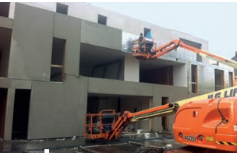
Bij de montage waren het enkele lange dagen met heel wat bekijks in de straat, maar het eindresultaat mag er absoluut wezen Lors du montage, il y a eu de très longues journées et des regards ébahis dans la rue, mais le résultat final y est.
