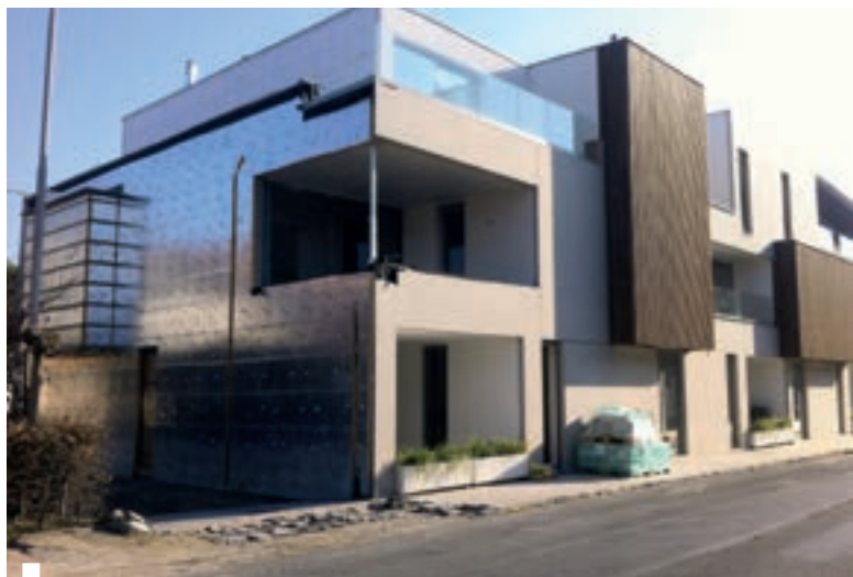
Het gebouw werd volledig ingepakt in harde PUR-platen, dikte 10cm voor de wanden, dikte 12cm voor de daken. Le bâtiment a été complètement emballé dans des panneaux durs de PUR, de 10cm d'épaisseur pour les murs et 12 cm d'épaisseur pour les toits.
