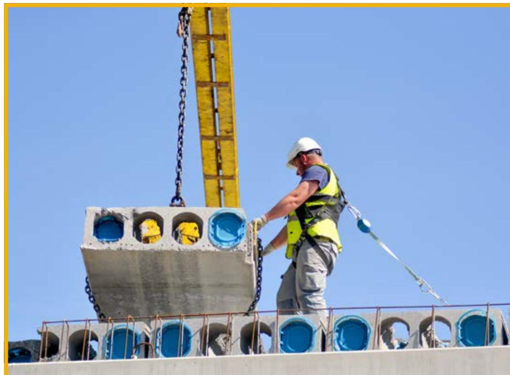
Komen de raam- of deuropeningen tot op het vloerniveau, dan kan in het betonnen kaderelement een randbeveiliging worden aangebracht in de vorm van twee wapeningsstaven. Dankzij deze voorziening is ook bij deur- en raamopeningen het valrisico onder controle en moeten er geen extra maatregelen meer genomen worden. In de afwerkfase kan de randbeveiliging gemakkelijk worden afgeslepen voor de plaatsing van de invulelementen.
