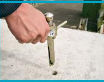
*De prefab elementen in de fabriek voorzien van ingestorte buizen, schroefhulzen en uitsparingen, kan zeker bijdragen tot de veiligheid op de werf.*
