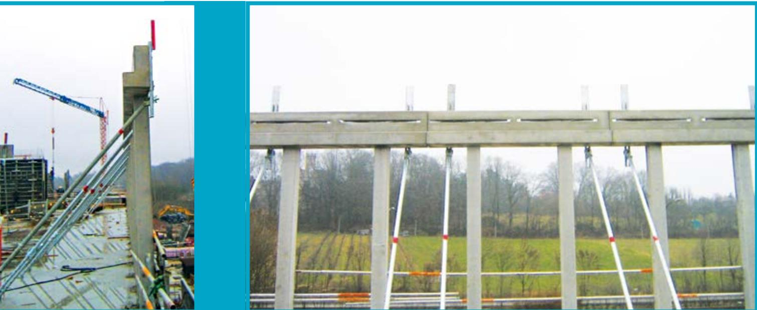
*Alvorens deze  $\pi$ -elementen te plaatsen worden de duw- en trekschoren en de leuninghouders bevestigd. Na de plaatsing van de vloorelementen kan onmiddellijk de randbeveiliging van de volgende verdieping al aangebracht worden.*
