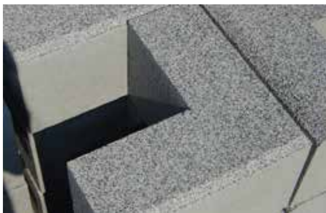
Boordsteen met gewassen toplaag
